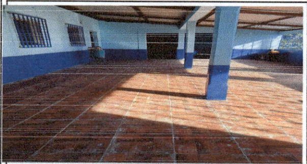
Sustitución de piso cerámico
