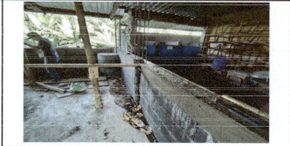
Reparación de muro perimetral de block.
